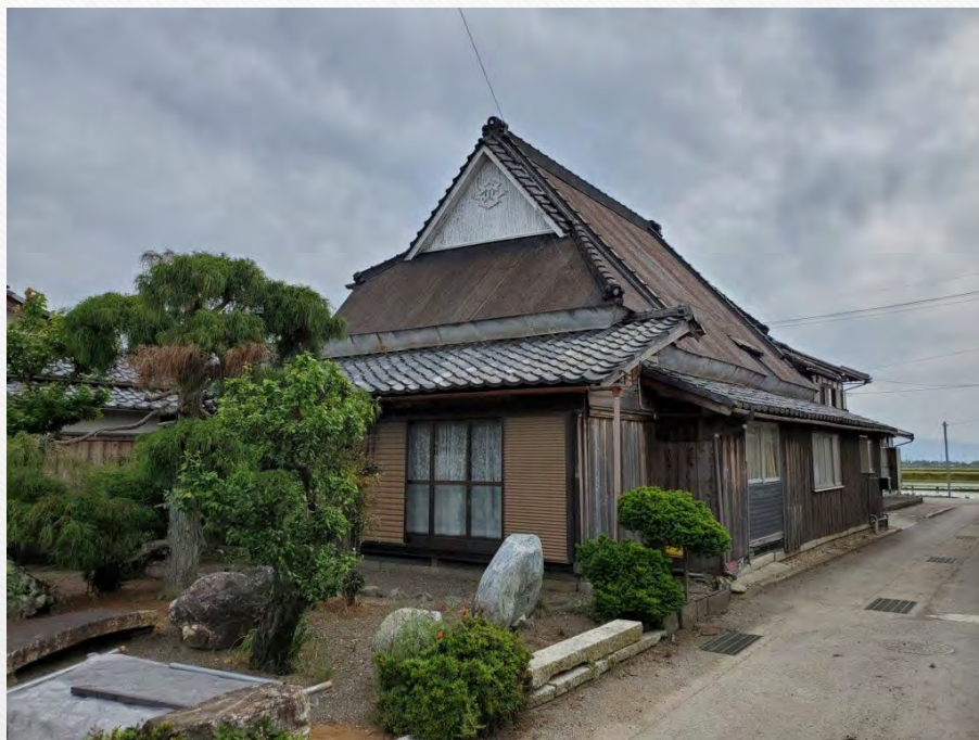
移築対象: 築98年 滋賀・長浜の茅葺の古民家
